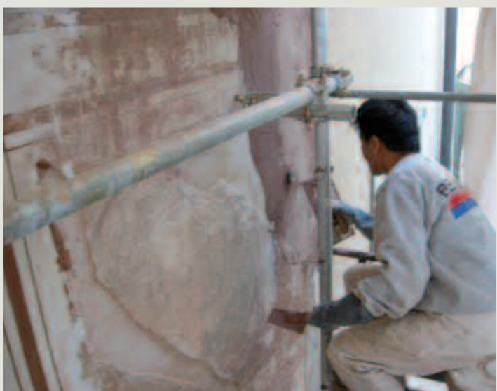
Alcune fasi operative dell'intervento: integrazioni e realizzazione del nuovo intonaco
