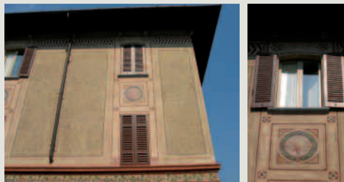
L'edificio dopo l'intervento
