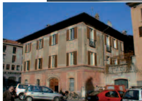
Prospetti, principale e laterale, dell'edificio prima dell'intervento. In alto l'edificio dopo l'intervento
