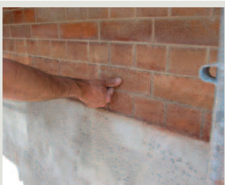
Particolari delle superfici al termine dell'intervento
