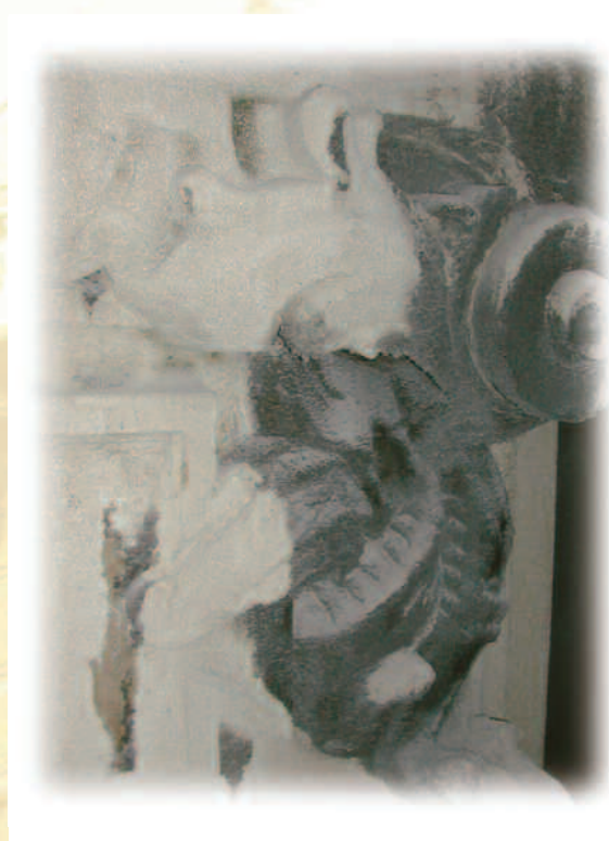
Esempio di deposito superficiale diffuso, di spessore variabile, composto da polvere, particolato atmosferico alla cui stratificazione non sono estranei i fumi derivanti dalla combustione delle macchine e di croste nere in parte già rimosse durante la fase di pulitura (zona basamentale, elementi decorativi e balaustrini dei balconi).
