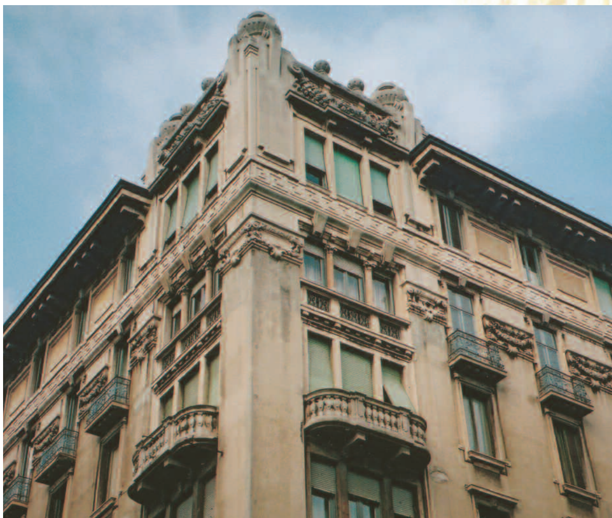
Un interessante esempio di facciata con una forte presenza di cementi decorativi.
