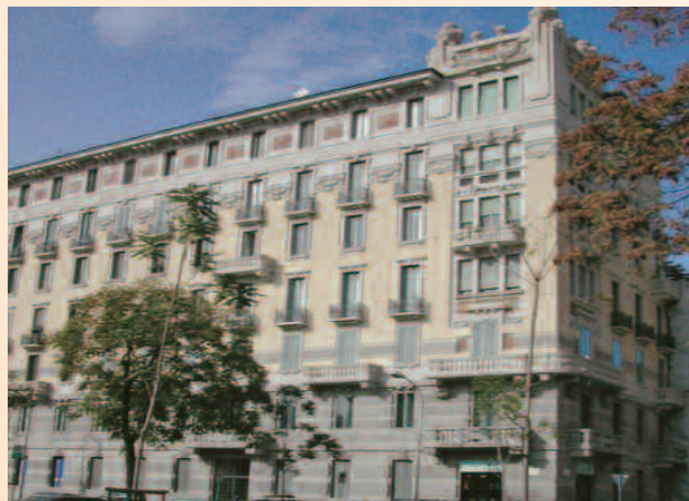
Facciata con decorazioni in cemento decorativo. Si riconosce l'evoluzione stilistica degli anni '20-'30 (opera di A. Campanini del 1924).
